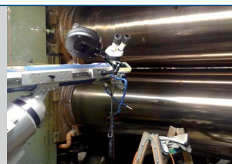
Reparaturschweißen an Walze (Foto: tcms, Gummersbach)
